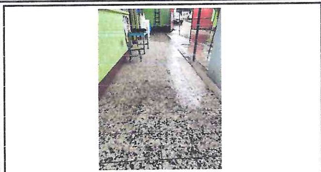
Foto1: Sustitución de Piso de Granito por Ceramico
