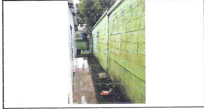
Foto 4: Pintura en Muros Interiores y Exteriores
