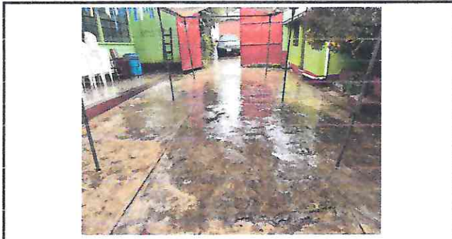
Foto1: Mantenimiento de Portones de Metal
