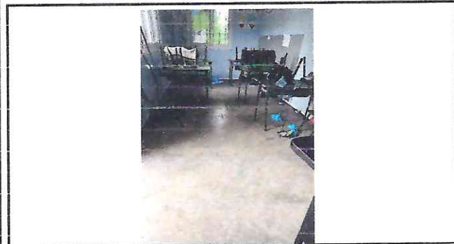
Foto 3: Reparación de Piso de Torta de Concreto
