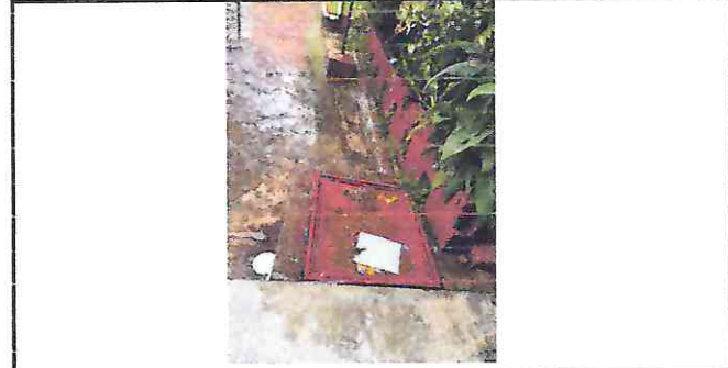
Foto 6: Reparación de Tapadera de Caja
